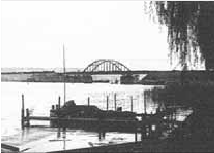
Aus dem Bildbericht des MfS vom September 1956 über die Baustellen am Berliner Außenring – hier die Baustelle am Templiner See. Quelle: BStU, MfS, BV Potsdam, Objektvorgang 110/58, Bd. V, Bl. 264.
