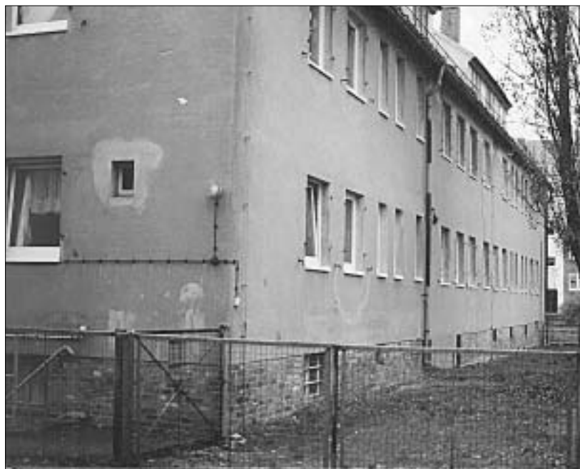
Abb.11: Ketschendorf, weitgehend originale Ansicht einer Unterkunft, 1996
