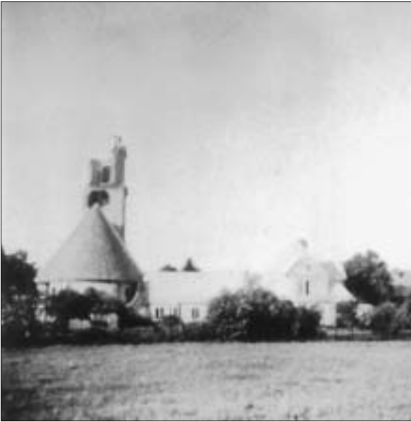
Die noch vom Krieg zerstörte Kirche von Halbe.
