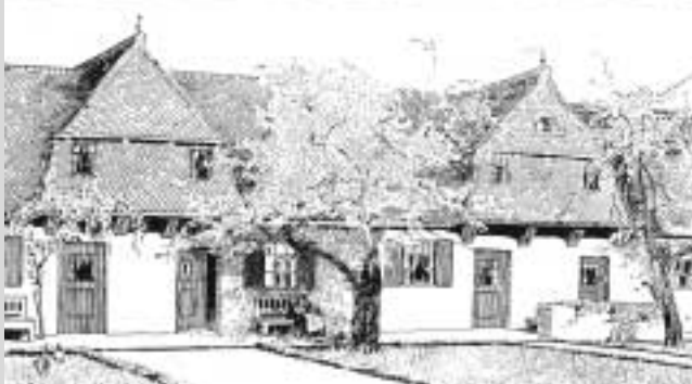
Zwei zusammengebaute Familienhäuser 1906, In: Heinrich Tessenow – ein Baumeister, Hg.: Wangerin, G./Weiss, G., Essen 1976, S.179
