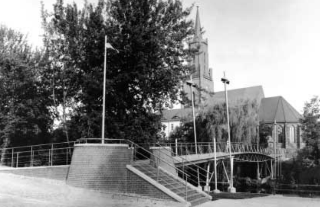
Kirchberg-Brücke in Rathenow Foto: Büro Dietrich
