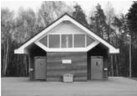
Standardtoilette Autobahnraststätte Foto: Complian
