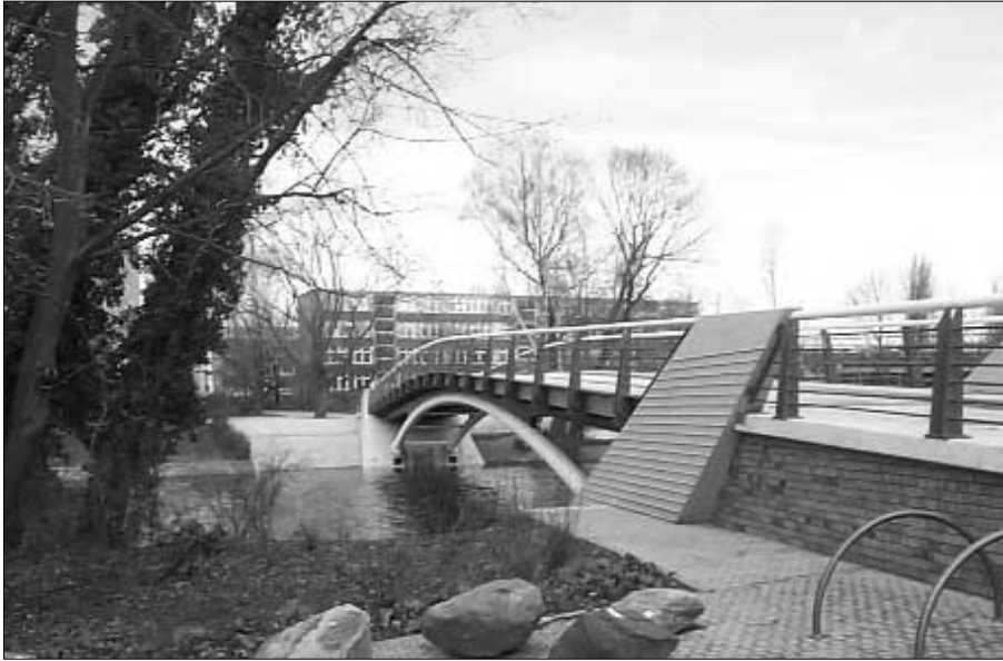
Inselbrücke, Potsdam. Foto: VIC Brücken und Ingenieurbau GmbH
