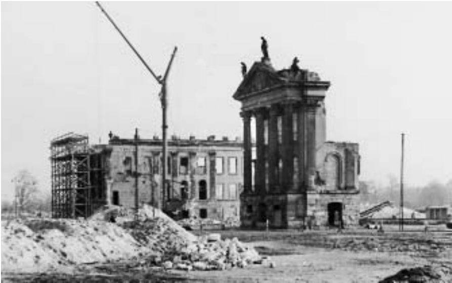
Abrißarbeiten an der Marktseite des Stadtschlusses, 1960
