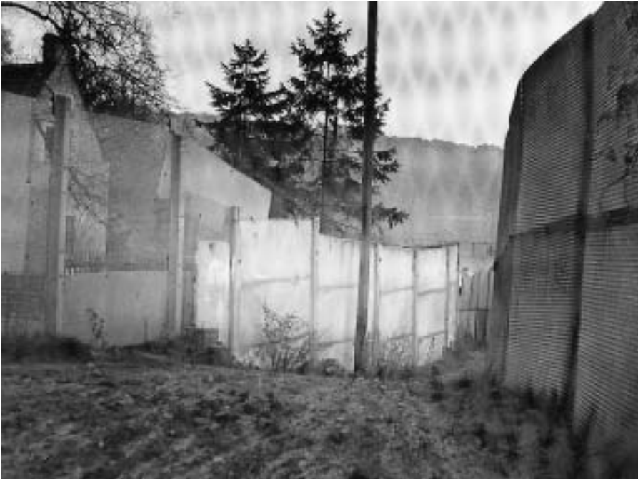
Mauerabschnitt bei Klein-Glienice, 1989
