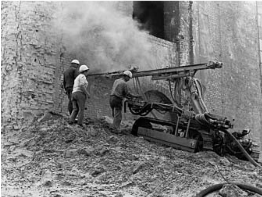
Sprengvorbereitung am Turm der Garnisonkirche im Juni 1968
